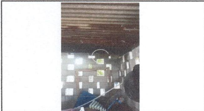
Foto1: Sustitución de lámina, por lámina troquelada aluzinc calibre 26. En cocina
